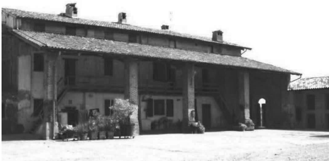
Figura 4 - Cortile interno cascina Malpensata Sopra
