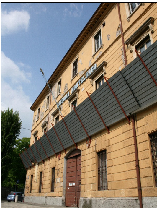
Illustrazione 5: Ex caserma Montelungo, facciata. (Fonte: Decreto di Vincolo n. 278)
