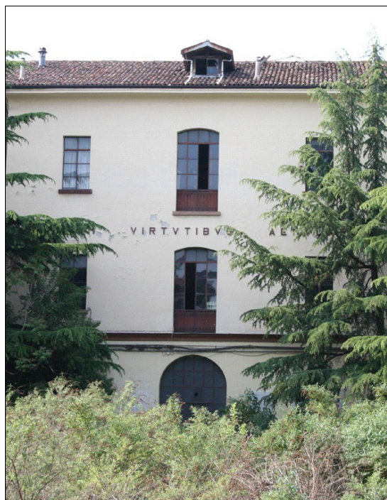
Illustrazione 6: Veduta dal cortile interno. (Fonte: Decreto di Vincolo n. 278)
